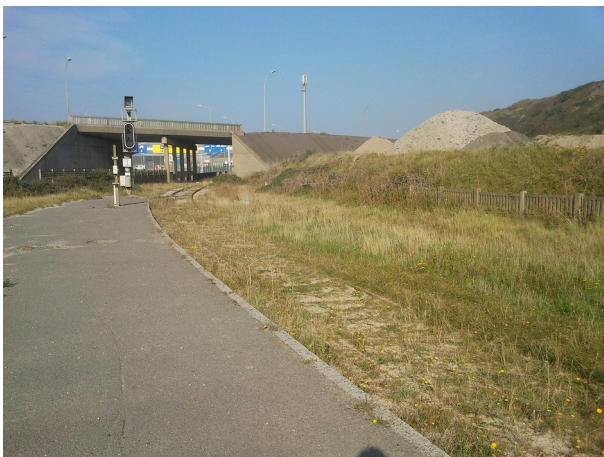
en 2015 Ancien quai de gare de Boulogne-Aéroglisseurs.
